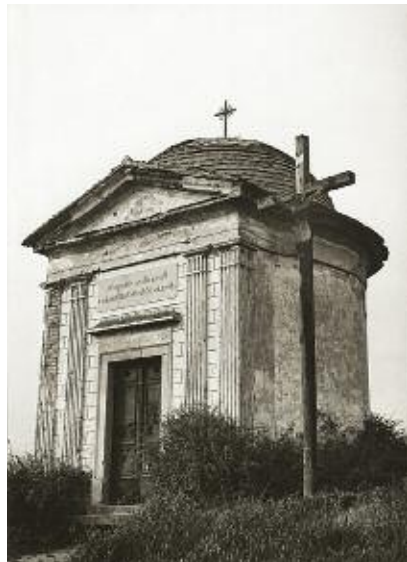
Cholerová kaplnka svätého Kríža Cholera Chapel of the Holy Cross
