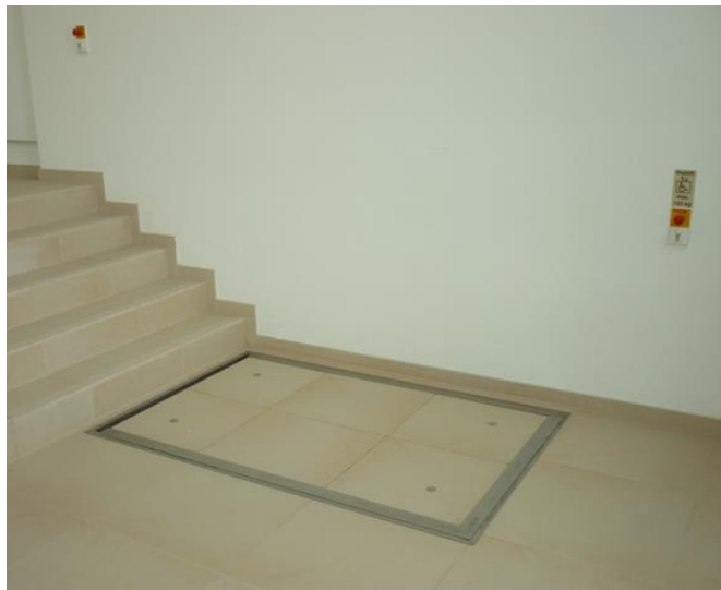
Hydraulická plošina pred schodmi https://www.at-c.de/en/hydrolift-en.html#ht100
