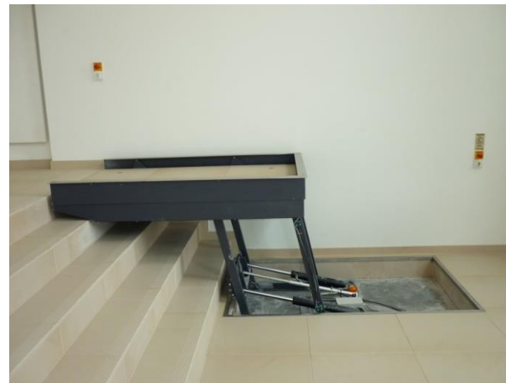
Hydraulická plošina pred schodmi https://www.at-c.de/en/hydrolift-en.html#ht100
