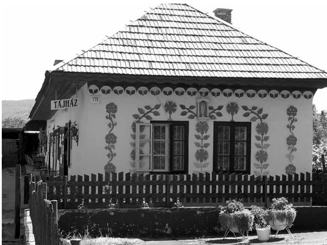
Pamätný dom ľudovej architektúry v Salka slúži aj na kurzy remesiel, ktorým sa venovali naši predkovia. Na dvore stojí starodávna pec, v ktorej sa pri slávnostných príležitostiach dodnes pečie. FOTO: archív obce Salka
